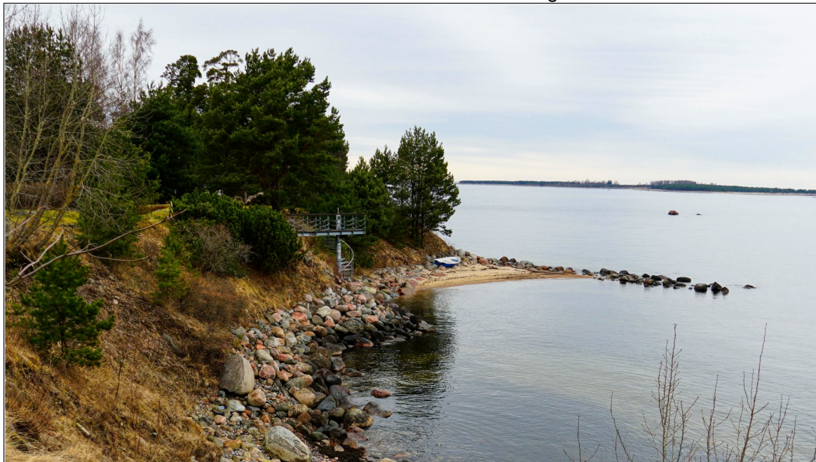
05: Vaade keerdtrepile astangu jalamilt (ümberehitatavalt kaldakindlustiselt).
